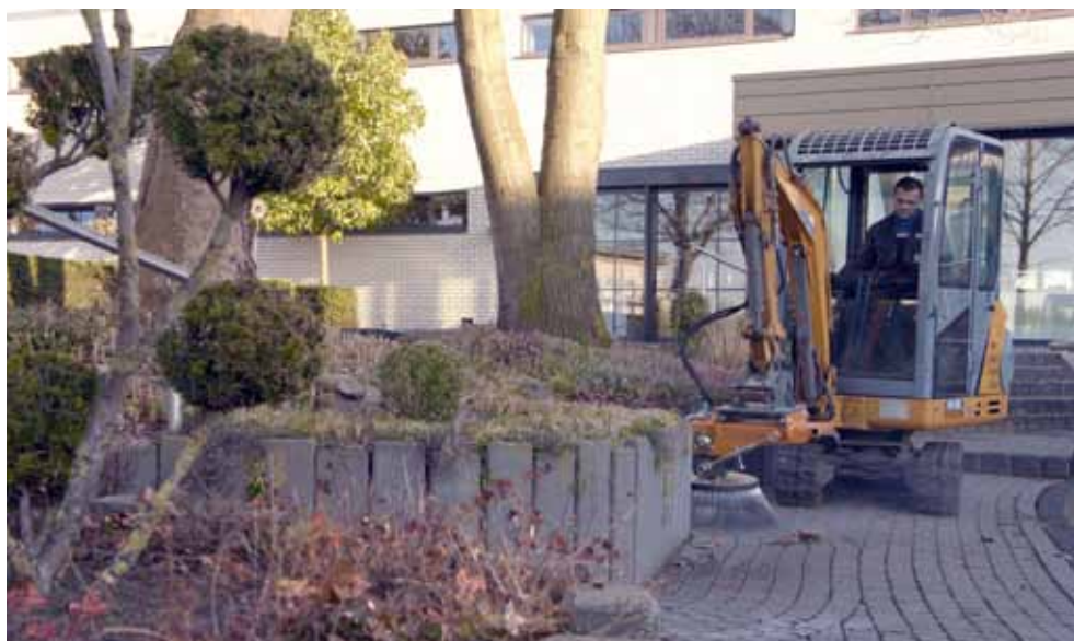
Wildkrautbeseitigung oder Reinigung von grobem Schmutz auf Baustellen mit dem wendigen Gespann aus bema Groby light und Minibagger.
