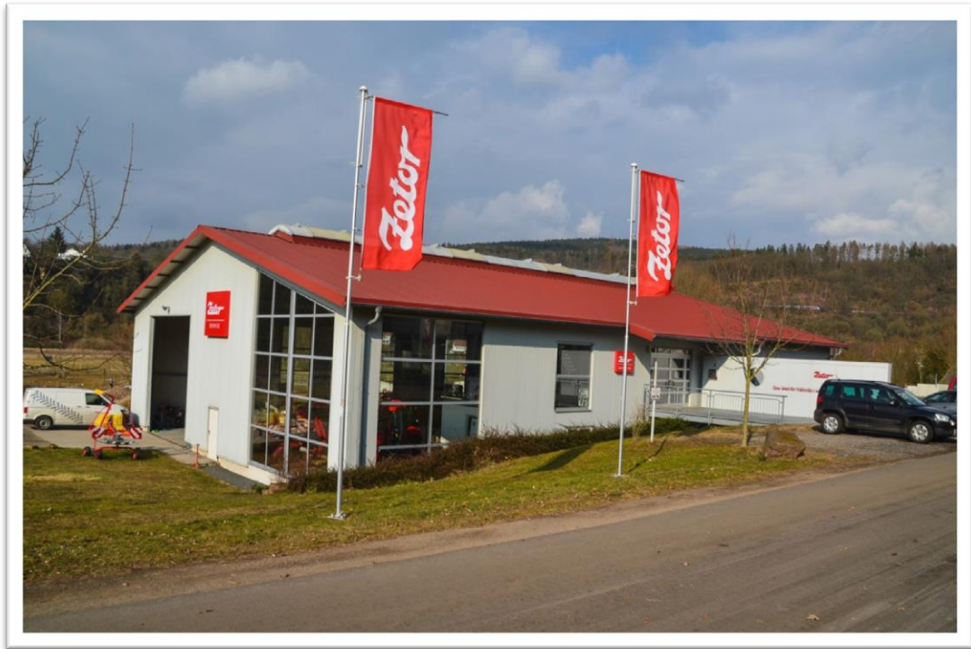
Außenansicht mit Eingangsbereich (Süden)
