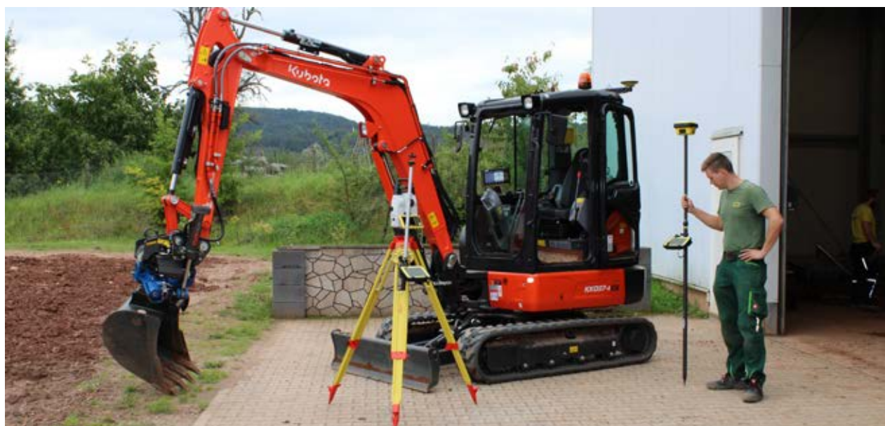
Die Teilnehmer des Seminars Digitale Baustelle konnten beim Thema digitales Aufmaß und 3D-Maschinensteuerung ein GNSS-System von Leica im Außengelände testen.
