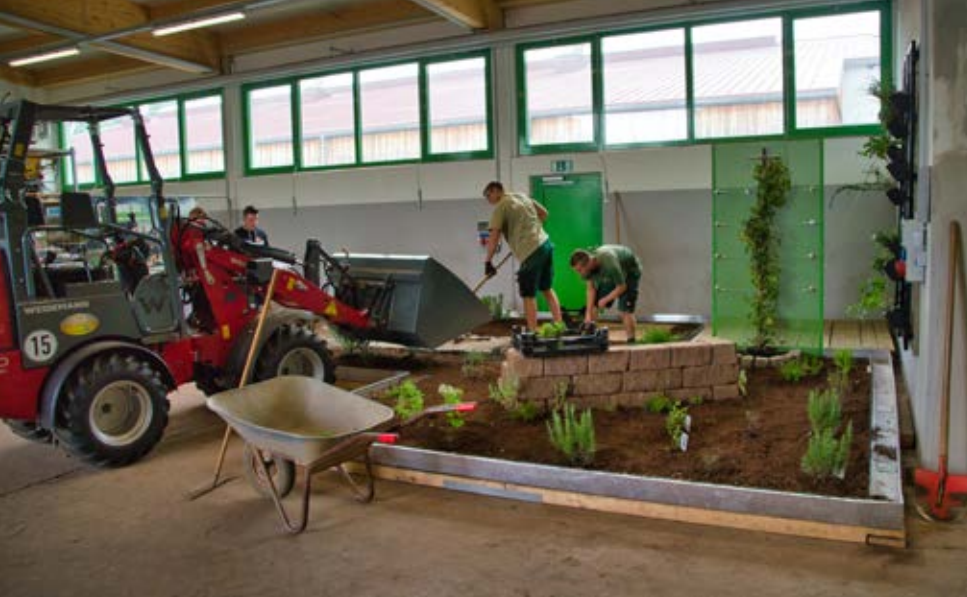
Der Lehrgang zeigt den Teilnehmenden die vielfältigen Möglichkeiten der Begrünung von Fassaden und die unterschiedlichen Aufbauten verschiedener Dachbegrünungsarten in Theorie und Praxis.
